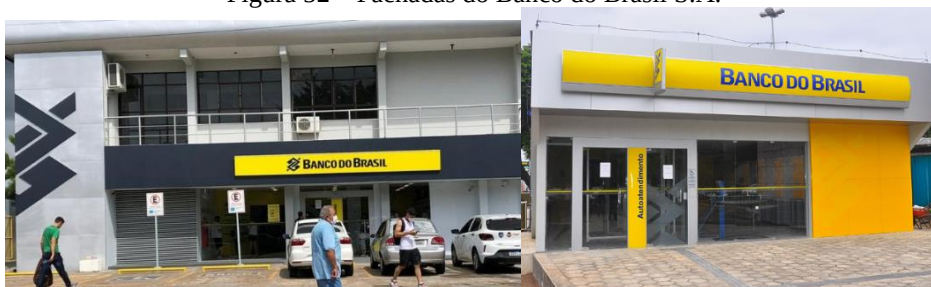
Figura 52 – Fachadas do Banco do Brasil S.A.
