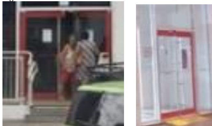
Figura 44 – Pórticos vermelhos nas fachadas do Banco Bradesco
